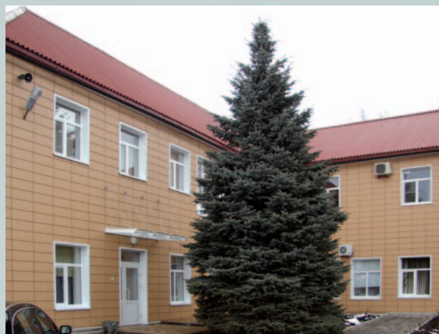
Fasády COTTA hliníkové fasádní extrudované profily dokonale svým designem nahrazující keramické obklady
